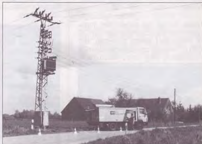
Prüfung einer Maststation in Hamminkeln:
