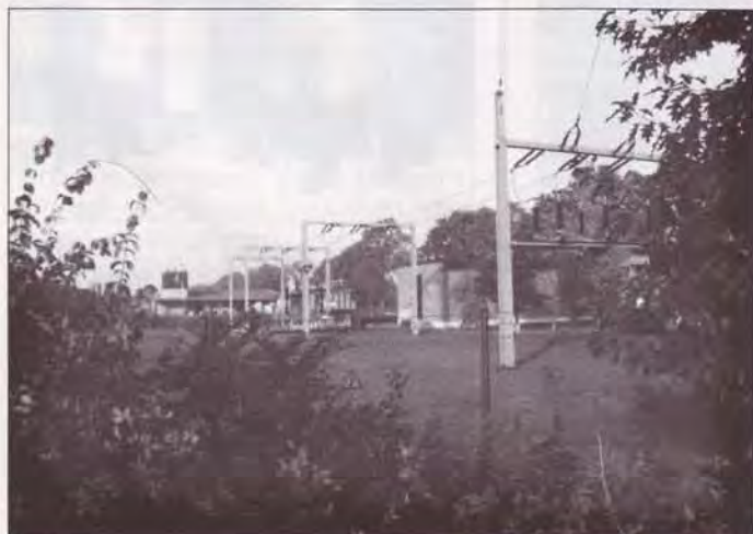
Die neue 110.000 Volt Umspannanlage an der Güterstraße. Die Spannung wird hier auf 10.000 Volt heruntertransformiert und so in die einzelnen Ortsteile verteilt.
