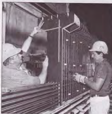
Binderfertigung Halle II.
