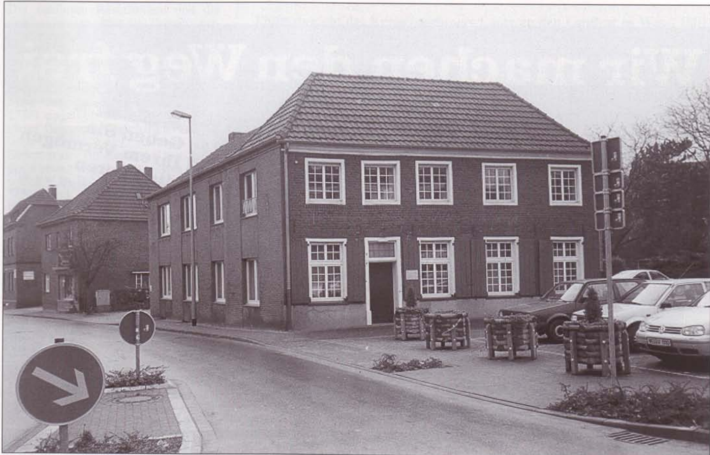
Das Foto vom November 1998 zeigt den „Schwan“ als Verwaltungsgebäude der Stadt Hamminkeln mit der heutigen Adresse Marktstraße 2.
