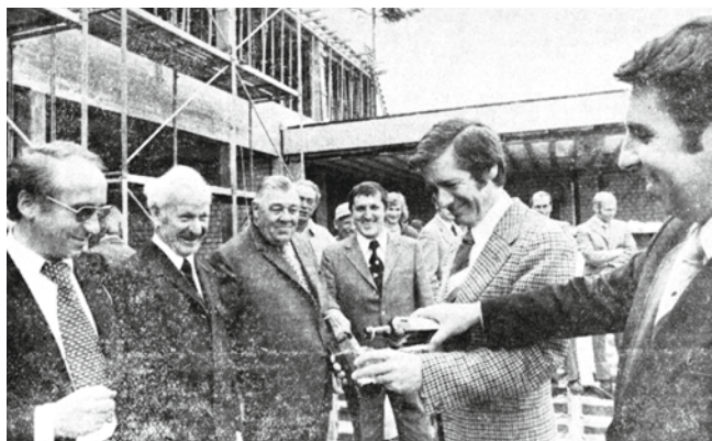
Einen Korn auf Hamminkels Hauptschulzentrum Mit einem zünftigen Richtschmaus, Eisbein mit Sauerkraut und klarem Korn, wurde das Richtfest des Hauptschulzentrums in Hamminkeln gefeiert. Begrüßende Worte sprach der Vorsitzende der Schulverbandsversammlung, Heinz Tittmann. Zu Beginn des Schuljahres 75/76 soll das Gebäude seiner Bestimmung übergeben werden. Das Foto entstand am 11.07.1974
