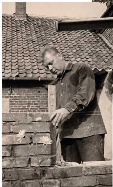
Bernd Grütjen beim Bau des Luftgewehrschießstands
