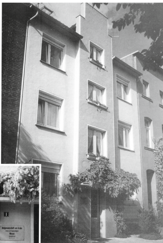
Das Haus Johann-Sigismund-Straße 1, in dem sich die Geschäftsstelle befindet, erbaut 1930 (Carl Termer), tlw. kriegszerstört, bis Mitte der 50er Jahre unbewohnbar, erworben 1.4.1957 ff. Generalinstandsetzung und verbesserte Ausstattung (3 WE).
