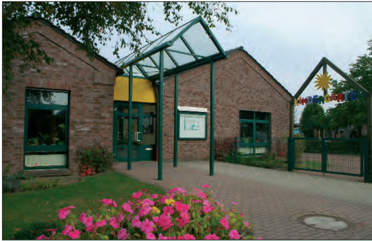
Vorderansicht Kindergarten „An der Windmühle“ Hamminkeln
