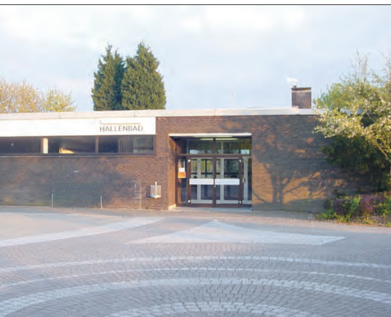
Das Hallenbad Hamminkeln vor dem Umbau
