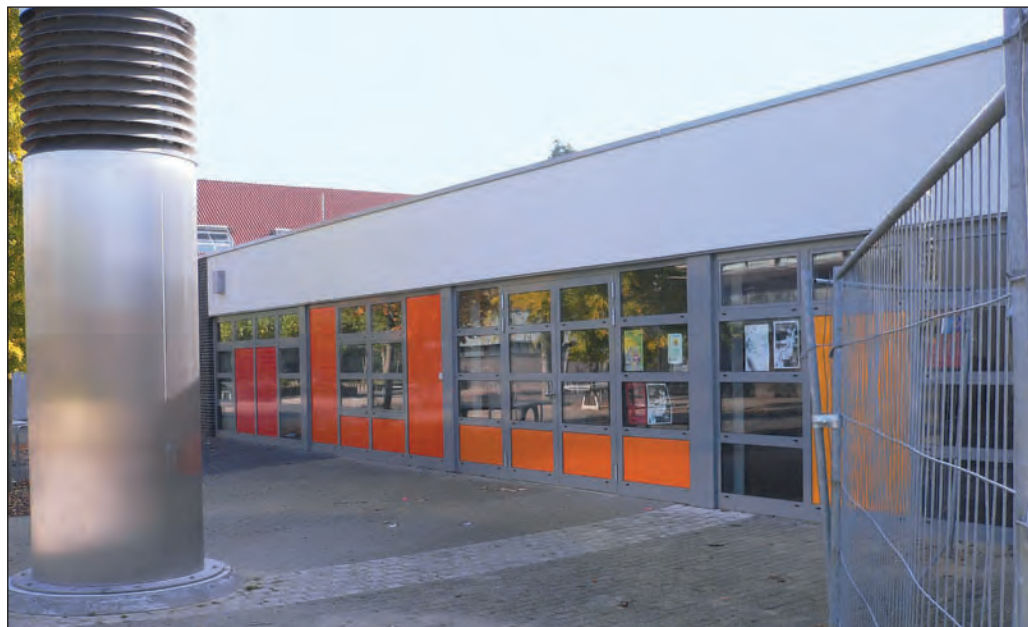
Fertigstellung des Jugendzentrums Hamminkeln zur Eröffnungsfeier am 10.09.2005
