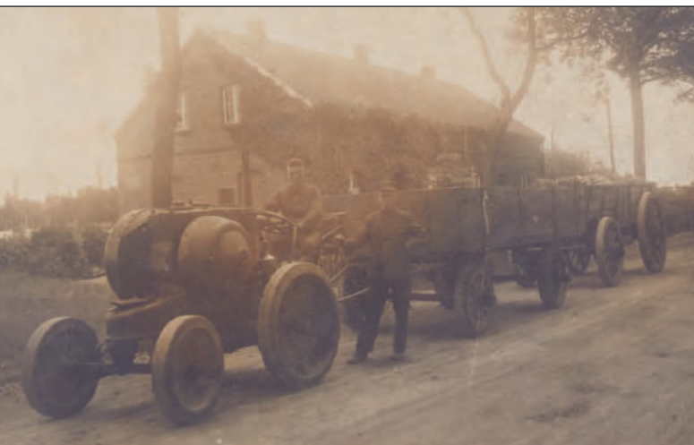
Schwere Frachtwagen mit Zugmaschine auf der Dingdener Straße in den 1930er Jahren, Die Fahrbahn besteht aus einer festge- walzten Schotterdecke.
