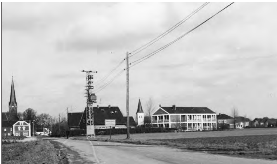
Die neue Katholische Volksschule an der Rathausstraße in Hamminkeln wurde am 20. März 1963 eingeweiht.
