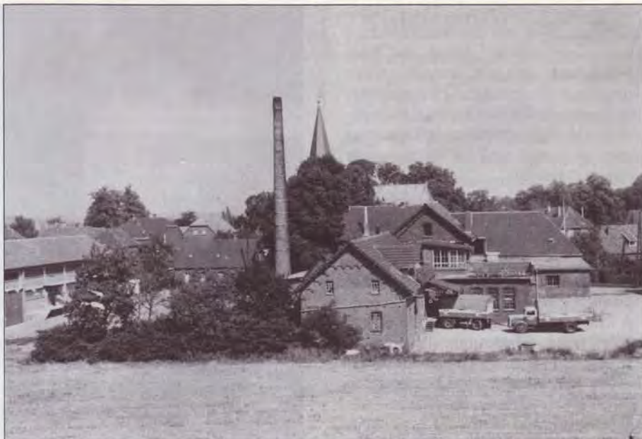
Blick auf die Molkerei Hamminkeln im September 1958. . .
