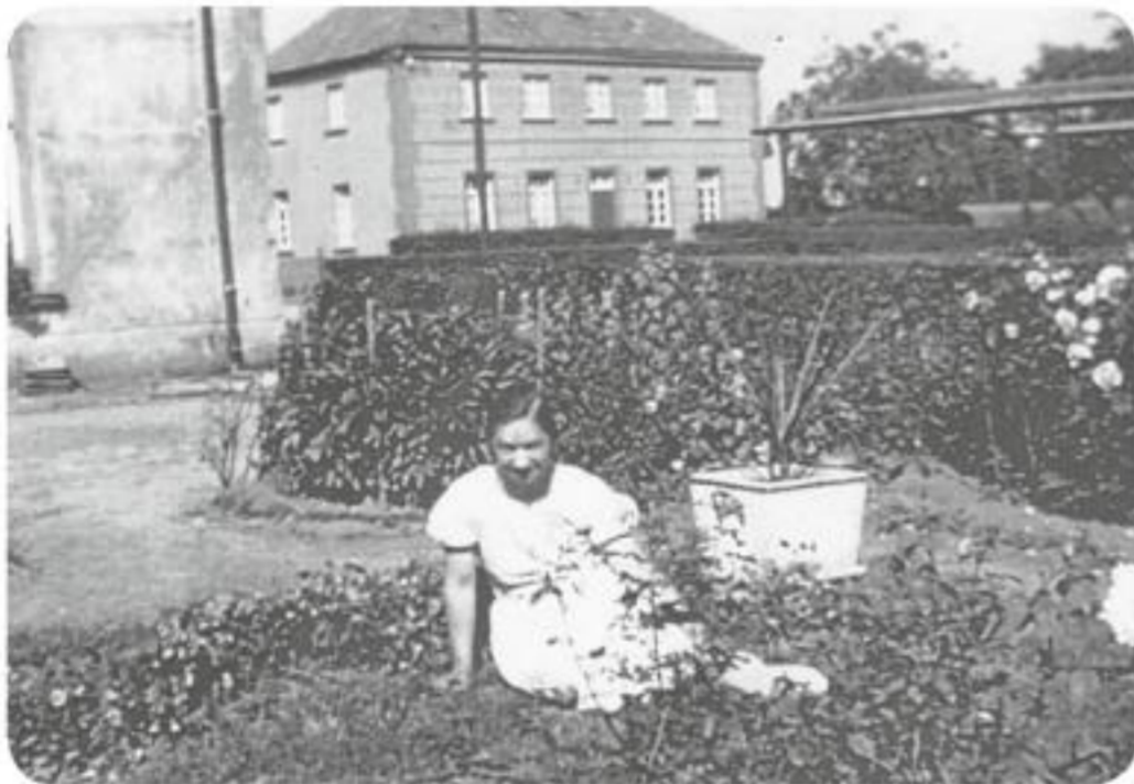
Ehemaliges Haus der Familie Siegmund Marchand, heute Brüner Straße 8. Das Haus, 1865 erbaut, wurde 1939 an die Firma Hans Kamps verkauft und im 2. Weltkrieg durch eine Fliegerbombe zerstört. Im Vordergrund Martha Kamps im damaligen Garten neben dem Haus der Familie Kamps (heute Parkplatz). Quelle: Rainer Kamps, Gaststätte Kamps
