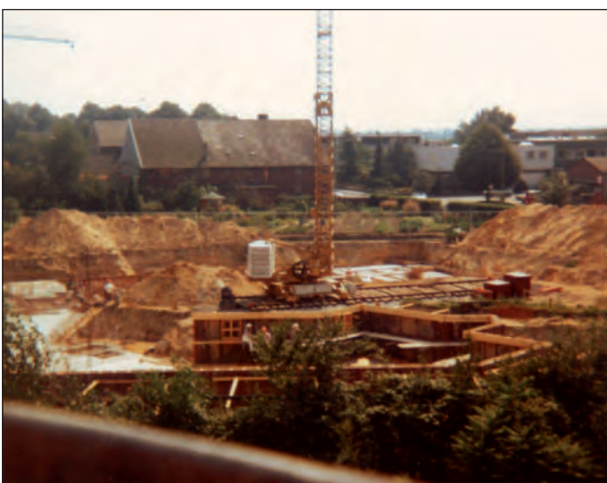
Die Rathaus-Baustelle im Sommer 1981.
