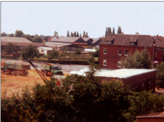
Die Baufahrzeuge für den Rathaus-Neubau rücken an. - Sommer 1981 - .Bildmitte im Hintergrund REWE, rechts Wohnhaus und Versicherung/Immobilien Storm und das ehemalige Stallgebäude Oertmann (helles Dach).
