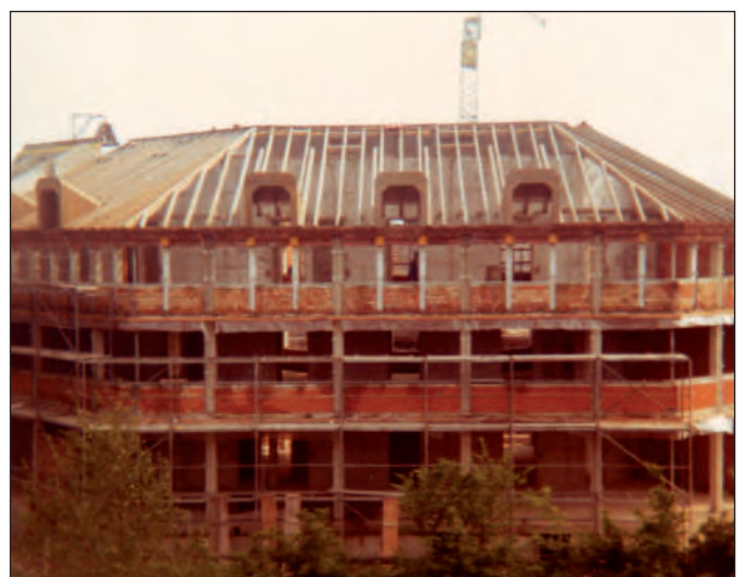
Richtfest des Hamminkeler Rathauses am 19. Mai 1982.
