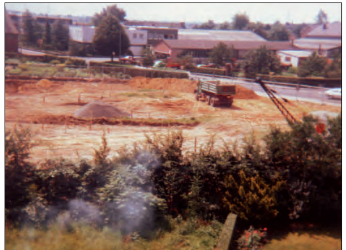
Die Rathaus-Baustelle im Sommer 1981. Bildmitte im Hintergrund Wohngebäude und Autowerkstatt Schneiders und Betriebsgebäude Schmiede Kamps sowie Garten Oertmann, heute Verbands-Sparkasse.
