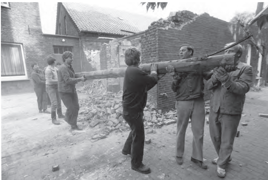
Mitglieder des Tambourkorps Hamminkeln bei Abbrucharbeiten des Hauses Tellmann 1986
