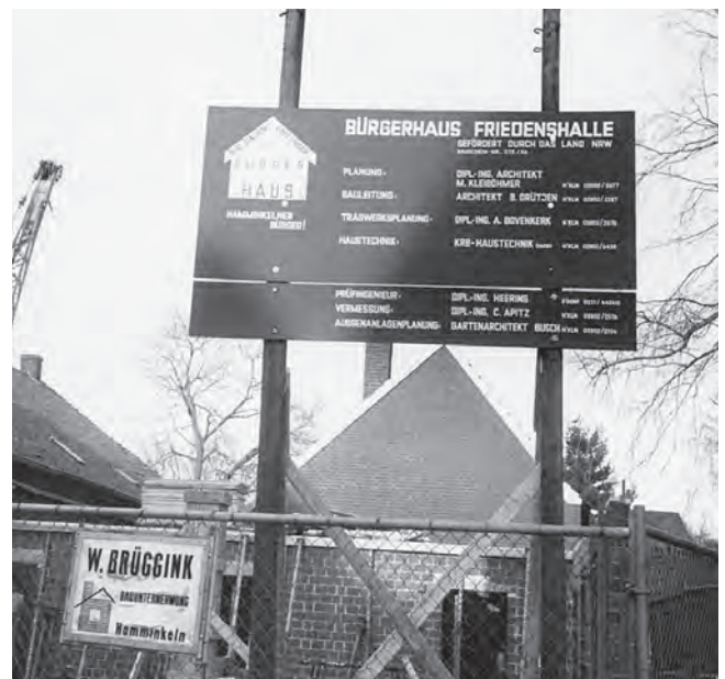
Die Bürgerhaus-Baustelle am 04.02.1987
