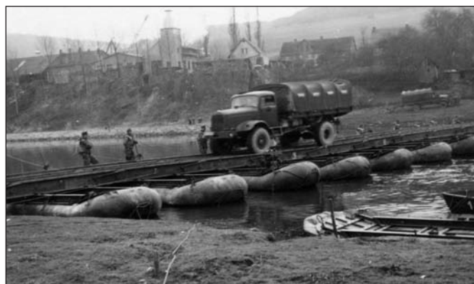
Heinz te Leuken als Pinoier im Einsatz beim Brückenschlag über die Weser 1959.
