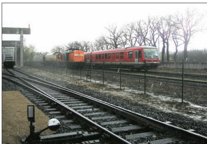
Foto: Max Bögl Fertigteilwerk Zugverkehr auf drei nebeneinanderliegenden Gleisen im Bereich des Bahnhofs Hamminkeln.
