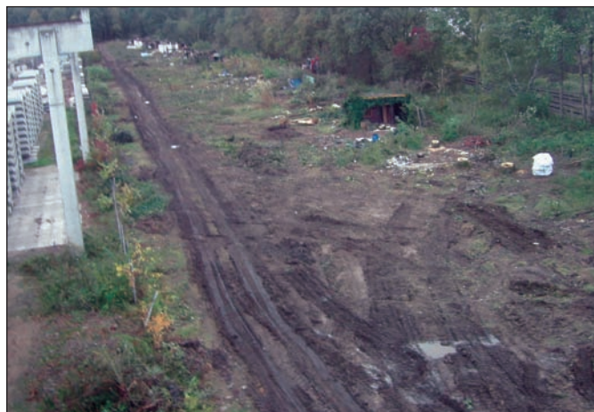
Foto: Max Bögl Fertigteilwerk Das Abräumen der Kleingärten und Fällen von ca. 80 Bäumen für den Gleisanschluss im Oktober 2009
