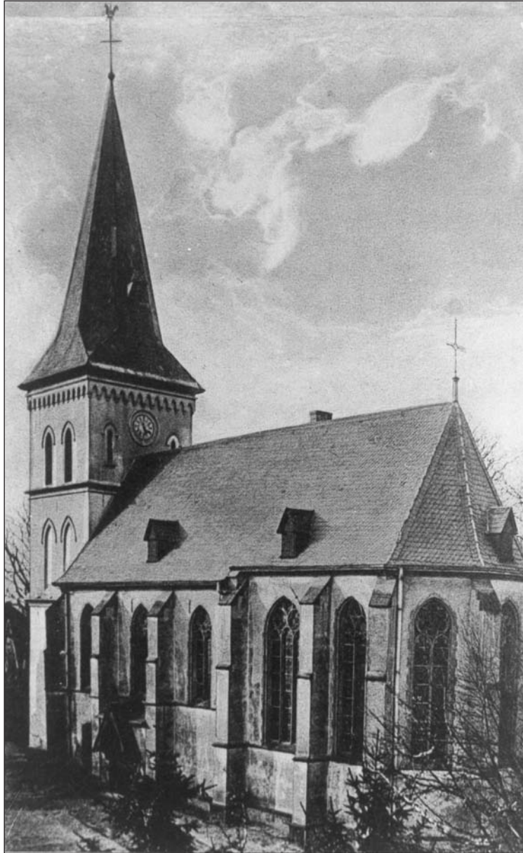
Evangelische Kirche, Zustand bis 1966, Ansicht von Süd-Osten
