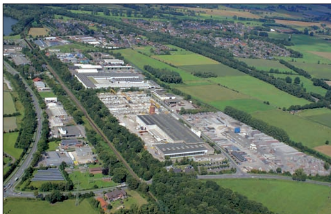
Foto: Max Bögl Fertigteilwerk Max Bögl Fertigteilwerk vor dem Gleisanschlussbau im Jahre 2008
