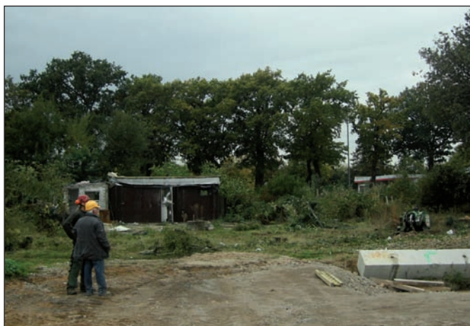
Foto: Max Bögl Fertigteilwerk Beginn der Bauarbeiten für den Gleisanschluss im Oktober 2009
