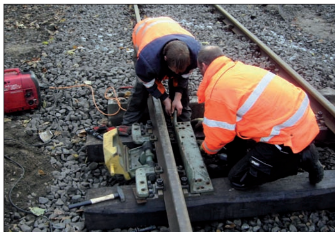
Foto: Max Bögl Fertigteilwerk Arbeiten an den Gleisanlagen
