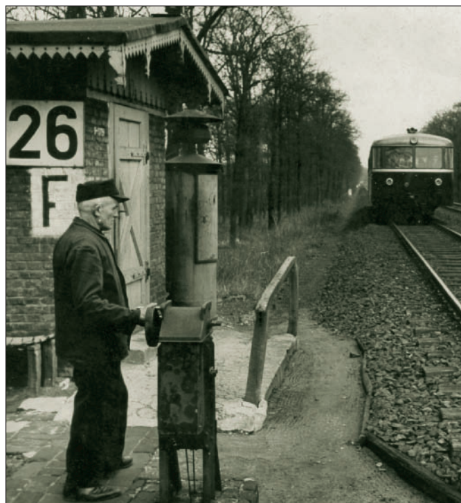
Fotosammlung: Wilhelm Berning Der Vater von Wilhelm Berning, Witzenskath 2, Schrankenwärter Heinrich Berning, geb. 24.02.1898 - gest. 17.05.1985, steht im Jahre 1950 an der Schrankenwinde vor seinem Bahnwärterhäuschen Posten 26 an der Kastanienstraße in Hamminkeln (Hof Steenbeck, heute ist an gleicher Stelle eine Relaisstation in einem Betongehäuse eingerichtet). Die Posten waren streckenweise durchlaufend nummeriert Oberhausen - Emmerich gleich 1- 48. Der Posten 26 war das letzte Bahnwärterhäuschen zwischen den Bahnhöfen Wesel und Diersfordt. Unmittelbar vor dem Posten steht das Leutewerk, welches tagsüber betätigt wurde. Es waren je nach Fahrtrichtung des Zuges unterschiedliche Leutesignale. Nachts musste der Bahnwärter den passierenden Zügen Leuchtsignale geben. Das „F“ bedeutet Fernsprecher vorhanden. Der aus Emmerich ankommende Schienenbus der 1. Generation war bei den Fahrgästen sehr beliebt und wurde auch in den Folgejahren weitergebaut.
