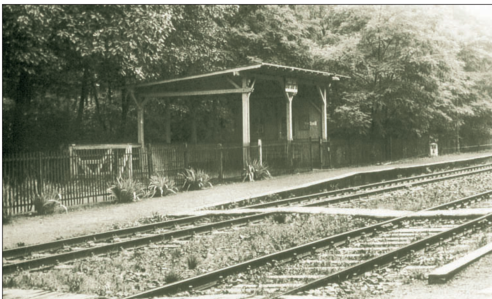
Foto: Kreisarchiv Wesel Der Haltepunkt Diersfordt im Jahre 1954. Blick auf die hölzerne Wartehalle am Gleis nach Wesel. Im Vordergrund der ebenfalls aus Holz gefertigte Straßenübergang über die Gleise.
